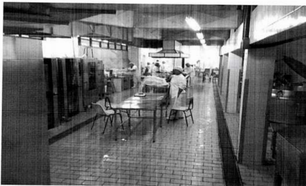
Foto 1 - Cozinha Industrial do Restaurante Universitário Central
